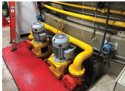
Transmissores de shutdown All-in-ONE (1XTXSW) no sistema de óleo lubrificante
