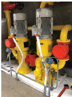
Transmissores de shutdown All-in-ONE (1XTXSW) no sistema de óleo lubrificante
